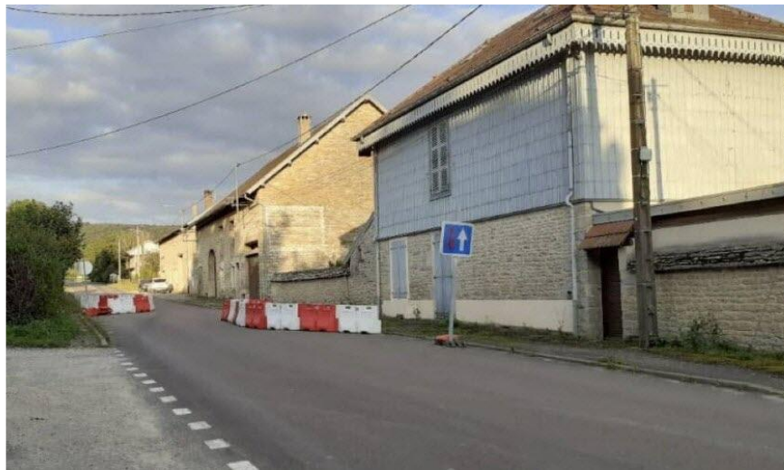
Des chicanes provisoires ont été placées rue Charles-Prillard en provenance de Besançon. Photo ER
